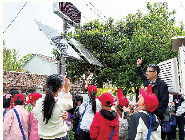
工作人员给小记者们讲解自动气象站的太阳能供电与数据显示系统。
